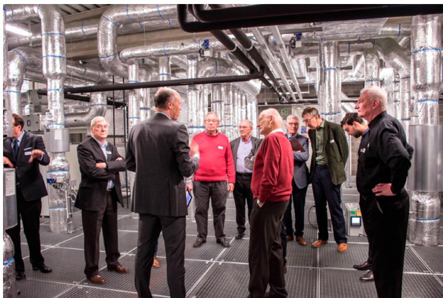
Een kijk achter de schermen van een modern onderzoekslabo: de indrukwekkende installaties die zorgen voor de luchtbehandeling en juiste druk in de cleanrooms. Benoit Moreaux, Chief Scientific and Technology Officer, geeft uitleg bij de technische installaties.
