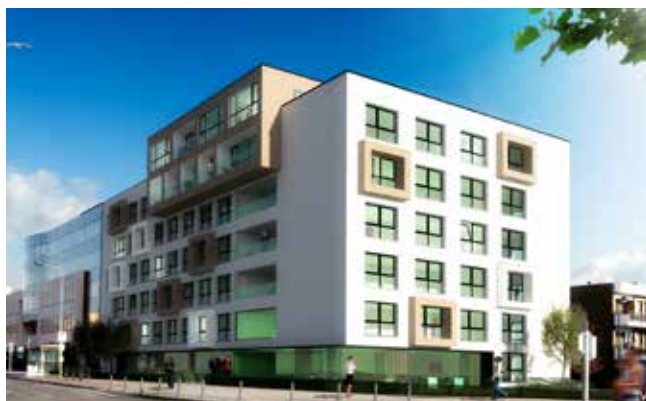
→ Project Maurice Charlent (Oudergem)
