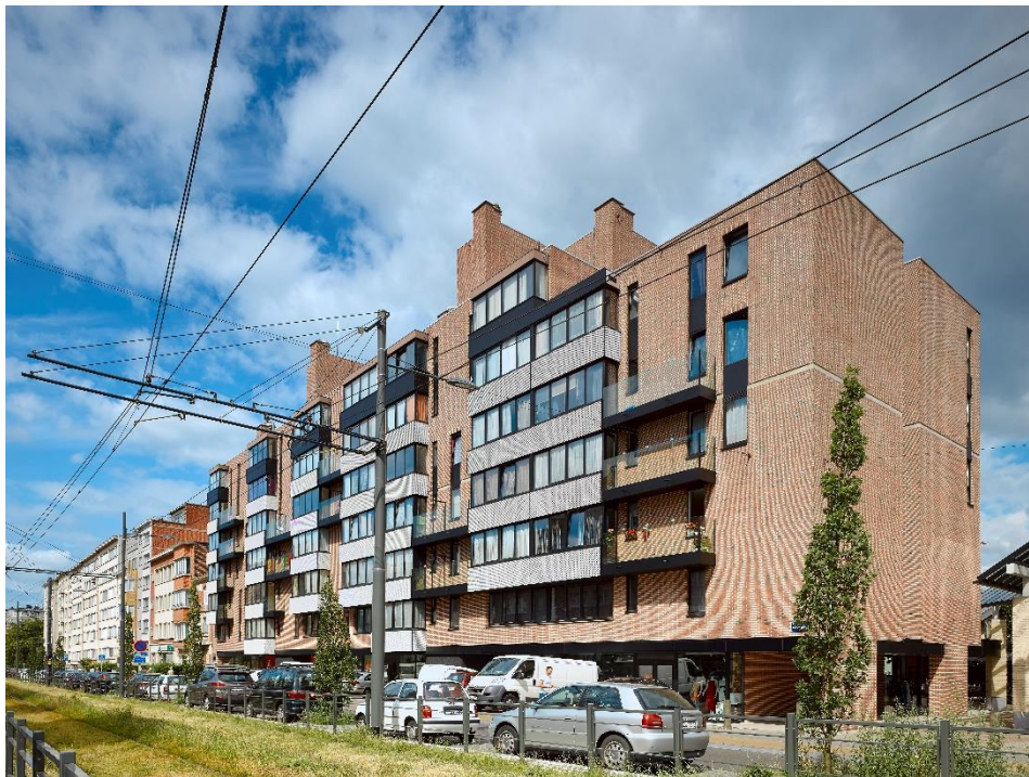
Charles Woeste na renovatie van de gevels
